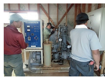
ポンプ場の保守点検
