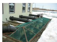
◎揚水機場金網修理
