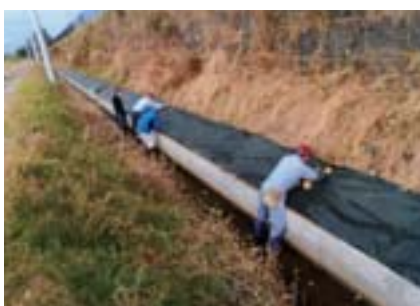
防草シートはりつけ作業
